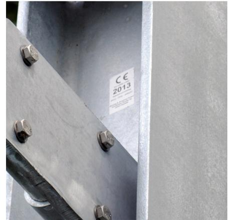
Abb. 4: Verbindungsmittel aus nichtrostendem Edelstahl in feuerverzinkter Stahlkonstruktion
