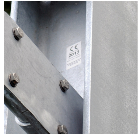
Abb. 4: Verbindungsmittel aus nichtrostendem Edelstahl in feuerverzinkter Stahlkonstruktion
