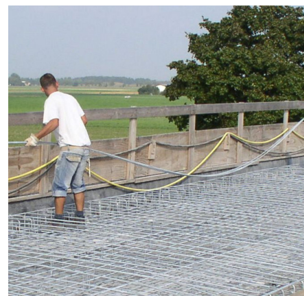
Abb. 2: Feuerverzinkter Betonstahl nach bauaufsichtlicher Zulassung Z-1.4-165
