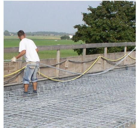
Abb. 2: Feuerverzinkter Betonstahl nach bauaufsichtlicher Zulassung Z-1.4-165
