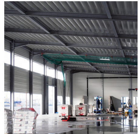
Abb. 1: Hallenkonstruktion mit R30-Brandschutz durch Feuerverzinken.
