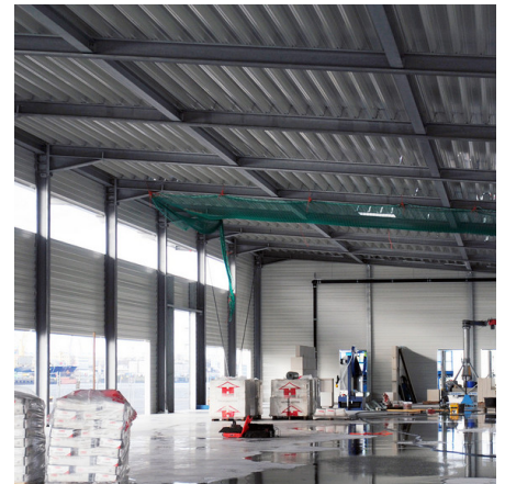
Abb. 1: Hallenkonstruktion mit R30-Brandschutz durch Feuerverzinken.
