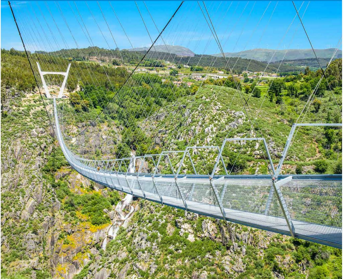
516 Arouca ist eine Hängebrücke in Arouca im Norden Portugals. Sie überquert die Schlucht des Flusses Paiva in 175 m Höhe. Mit 516 Metern gehört sie zu den längsten Fußgängerbrücken der Welt. Die Brücke besteht aus 127 jeweils vier Meter langen feuerverzinkten Stahlgittermodulen, durch die man bis zum Boden der Schlucht sehen kann. 516 Arouca wird von zwei Stahlseilen getragen, die an zwei Stahlbeton-Pylonen befestigt sind.
