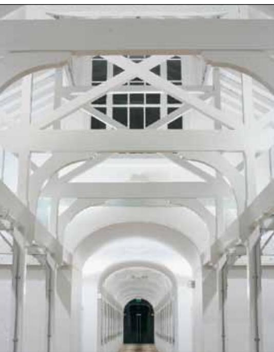
Das vorhandene Marktgebäude im Herzen von Tiverton wurde im ersten Drittel des 19. Jahrhunderts errichtet und umfasst eine Dachkonstruktion aus Holz, gusseiserne Säulen und einen Kern aus Mauerwerk.
