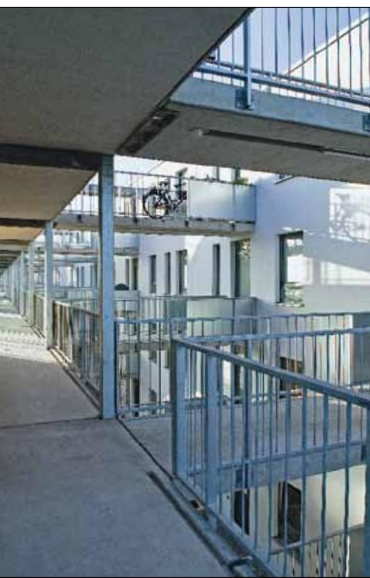
Die Gebäude verbindenden, offenen Laubengänge und Treppen wurden als eine Kombination aus Stahl- und Betonbauweise realisiert. Alle Stahl- und Betonteile sind vorgefertigte Elemente, die jeweils auf der Baustelle montiert wurden. Das Montagesystem beruht auf dem Prinzip eines Stecksystems, ähnlich dem eines Regals. Mit Bolzen und Muttern verbundene Elemente stellen den statischen Verbund mit den aussteifenden Gebäuden her.
