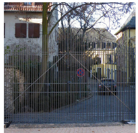
Abb. 3: Eine Feuerverzinkung schützt dauerhaft vor Korrosion, hier zusätzlich beschichtet als "Duplex-System".
