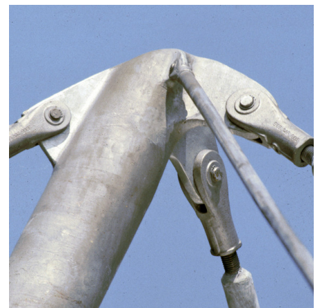
Abb. 3: Gabelköpfe und Haltesysteme sind zumeist aus feuerverzinktem Gussstahl.
