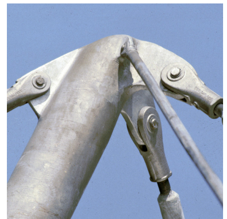
Abb. 3: Gabelköpfe und Haltesysteme sind zumeist aus feuerverzinktem Gusstahl.
